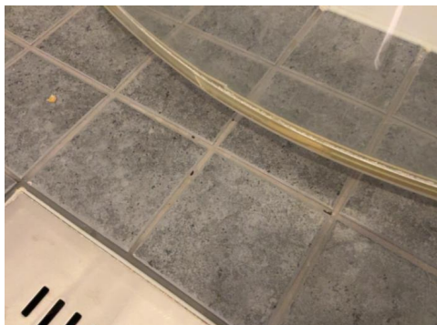
Små hull i fuge i våtsone
