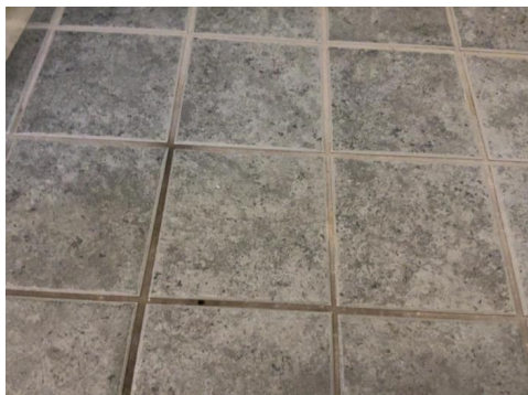
Små hull i fuge i våtsone
