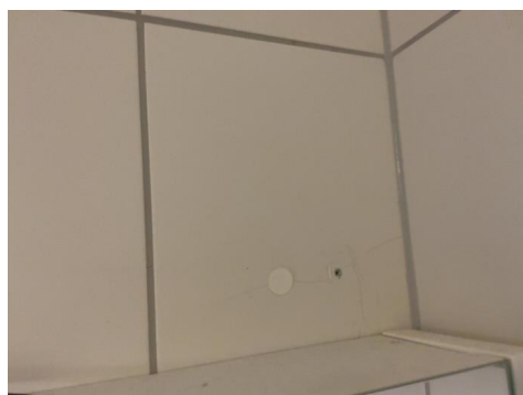
Sprekker i flis over speilskap.
